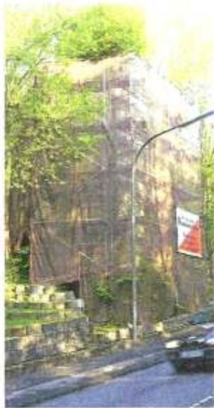
Der Turm ist seit Jahren eingerüstet. Archiv-Foto: Uwe Schinkel
