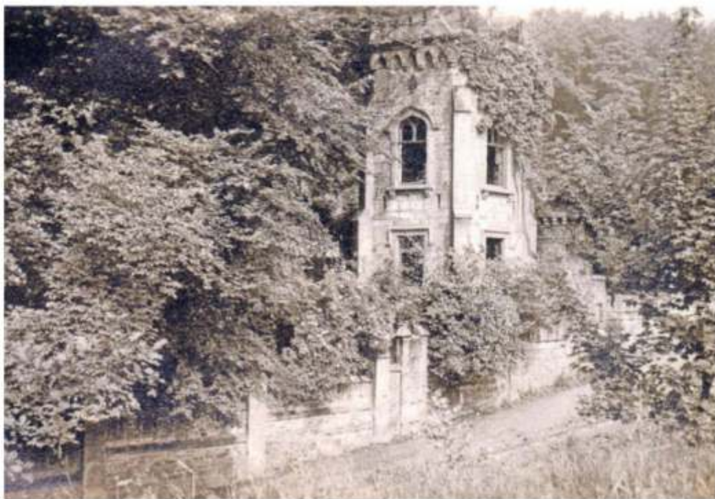
Der Belvedere-Turm der Villa Seyd an der Kohlstraße auf einer Ansicht um 1930.
