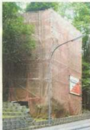
Seit Herbst 2007 ist der Turm an der Kohlstraße eingerüstet.
